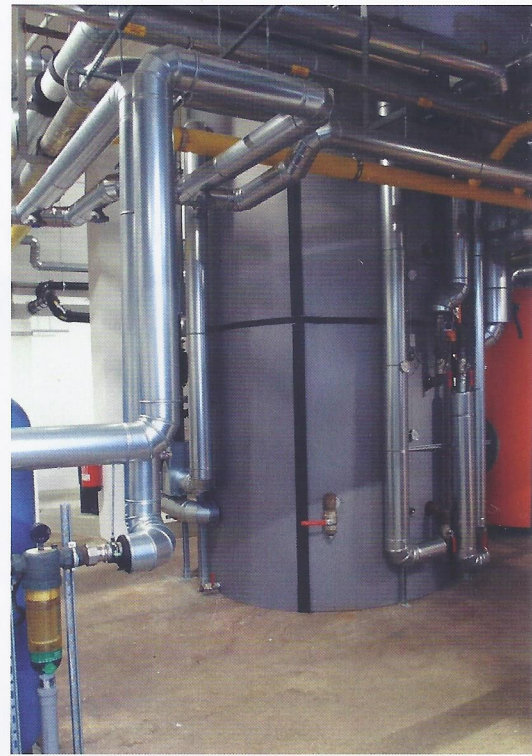
Der Pufferspeicher mit seiner Kapazität von 8.800 Litern hat dem BHKW eine hohe Laufzeit ermöglicht.
